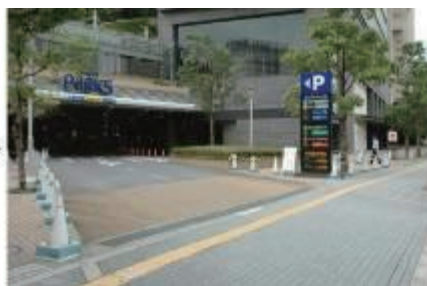
2. 停车场入口处
