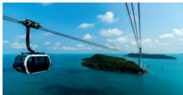
Cáp treo vượt biển dài nhất thế giới World's Longest 3-wire Sea-crossing Cable Car
